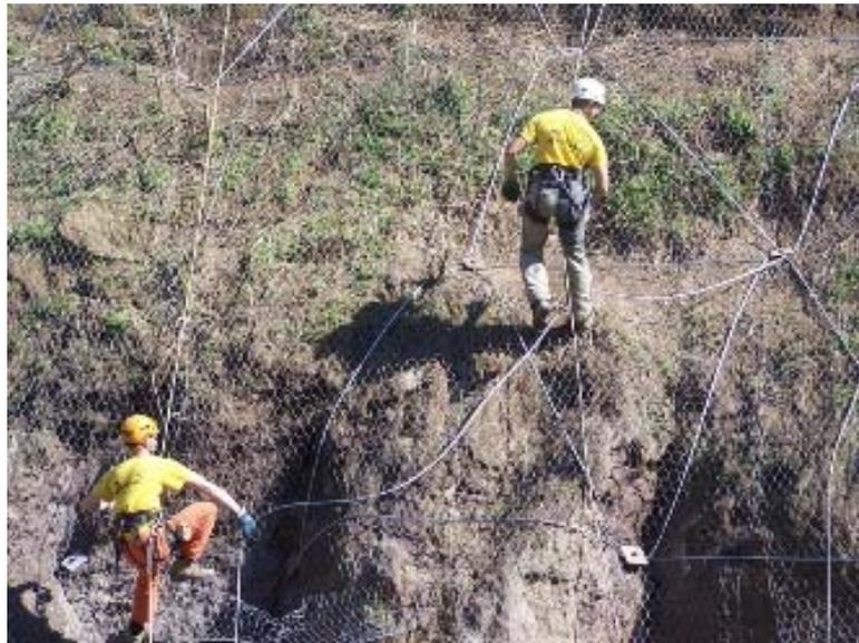
*Esempio di intervento similare realizzato sul versante tufaceo di via Atigliana in Sorrento, con l'apposizione di rete armata con chiodature attive e rinforzata con funi metalliche.*
